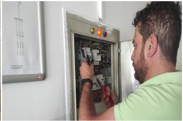
Elektrik Panolarının Kontrol Edilmesi ve Gerekli Düzenlemelerin Yapılması
