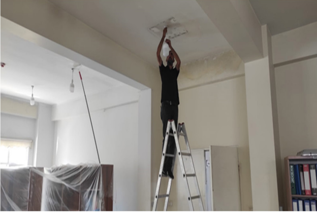
Arızalı Armatür, Lamba ve Anahtarların Değişimi
