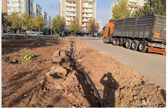
Tesisat Ekibinin Park Alanlarındaki Anahat Boru Onarımı
