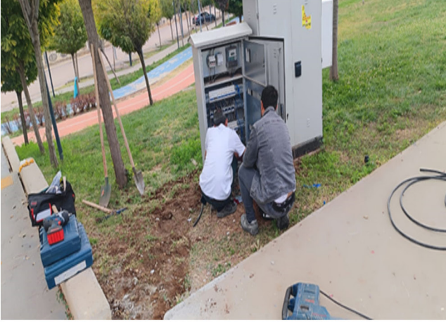
Park Alanlarındaki Yer Altı ve Yer Üstü Elektrik Kablolarının Yenilmesi
