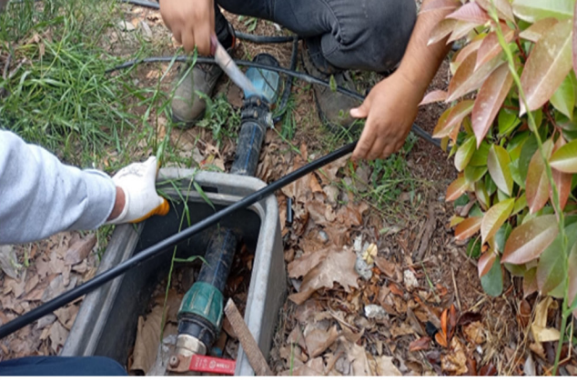
Fidanlık Alanındaki Dizili Ağaçlara Ahtapot Damlama Sistemi Kurulumu
