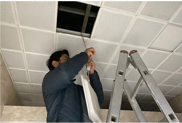
Arızalı Armatür, Lamba ve Anahtarların Değişimi
